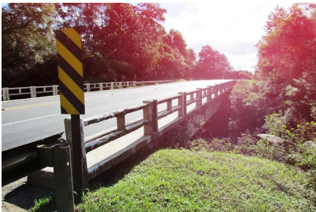
Foto 04 Vista lateral longitudinal do lado Leste da ponte.
