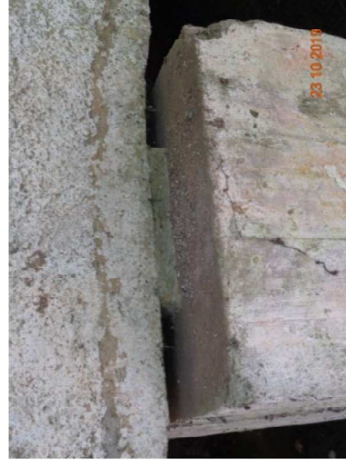
Foto 4. Vista do aparelho de apoio em bom estado.
